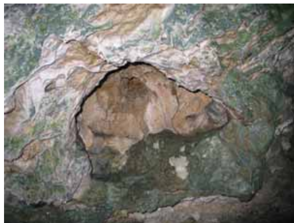
Slika 35: Stropna kotlica. Ceiling pocket.
