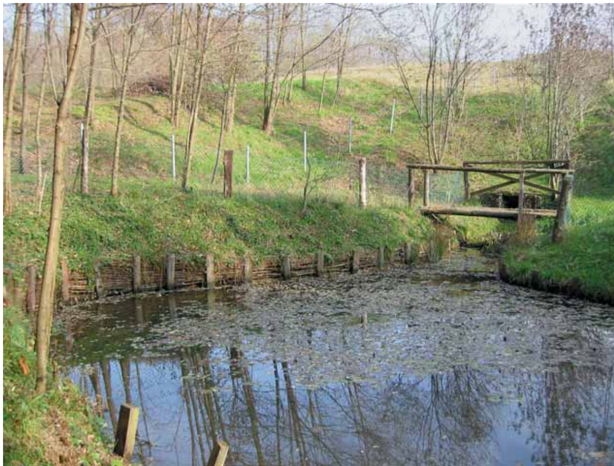
Fig. 6 - Fontana Bocchino, a lato della Strada Dorsale, tra le Prese XIII e XIV. Uno specchio d'acqua, situato alle pendici di un ampio avvallamento prativo, raccoglie le acque sorgive intercettate dal manufatto di presa che si intravede in secondo piano nella foto, oltre il ponticello in legno di epoca sicuramente recente. Si tratta di una grotto di captazione, edificata con mattoni in croda. Si noti l'estrema cura delle sponde, fissate con fasci di rami a loro volta sostenute da tronchi; e la recinzione, fatta corre tutto attorno allo stagno, per chiudere l'accesso a questo laghetto privato.
