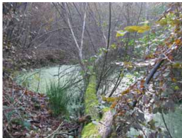
Fig. 3 - Fontana Rotola, localizzata a lato della Strada Dorsale tra la Presa XIV e la XIII sud. L'immagine offre un chiaro esempio del cattivo stato di conservazione della fonte: lo specchio d'acqua è coperto da una spessa lenticola verde, la vegetazione circostante e gli abbondanti detriti vegetali infestano questo sito, rendendone difficile anche l'accesso.
