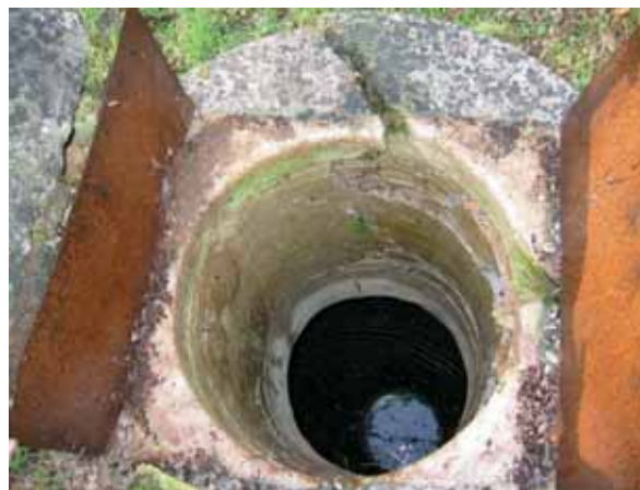
Fig. 5 - Fontana Padoia. L'interno del pozzo, visibile attraverso la vera in mattoni, è costituito da una camera sottostante in cemento, che raggiunge una profondità complessiva di almeno 4 metri; la chiusura è garantita da un sistema a due ante in ferro, bloccate in maniera rudimentale da un sasso (di qui il problema accennato di mancata sicurezza). Si intravede il livello dell'acqua ed il grado di limpidezza.
