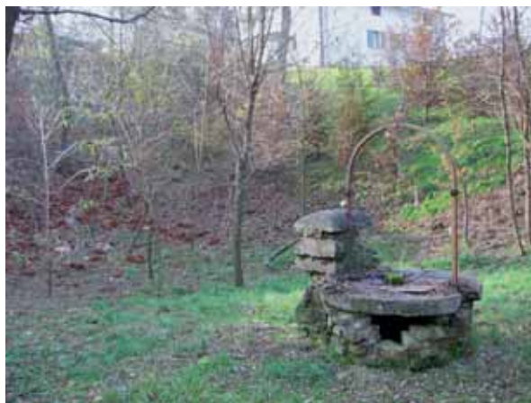
Fig. 4 - Fontana Padoia, Presa XVIII nord. Pozzo di presa sul fondo di una dolina, con assenza di specchi d'acqua. Il pozzo appare in buonissimo stato: conserva ancora la volta in ferro grazie alla quale venivano fatti calare i secchi nella cisterna sottostante; non compare più, ma sarebbe confermato da testimonianze, l'antica presenza di un mulinello in legno per l'avvolgimento della catenella di ferro legata al secchio.
