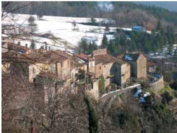
Figure 22 - Bâti du centre ancien de Méailles. Old buildings in Méailles village.
